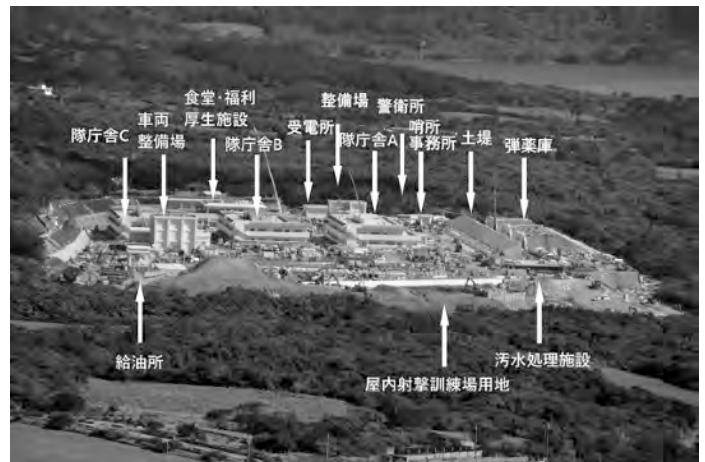
建設中の陸上自衛隊ミサイル基地
